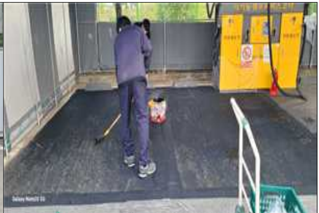
개선 작업 중
