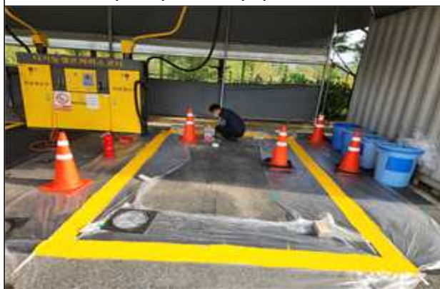
개선 작업 중
